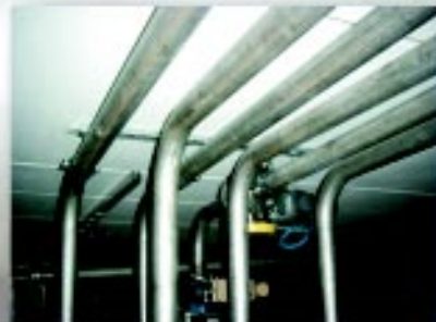
Molchrohrleitungen mit Einbiegungen Piggable pipes with inline bendings
