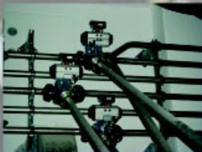
Rohrstaffel mit Molchweichen BR 29a Piggable piping with 3/2-way valves Series 29a
